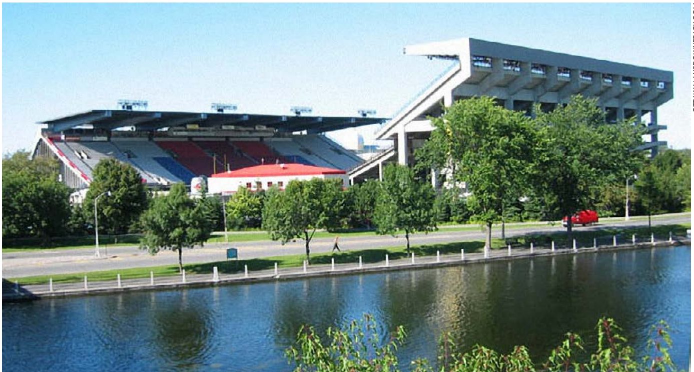
Une photo du Stade Frank Clair avant la démolition des estrades du côté sud
