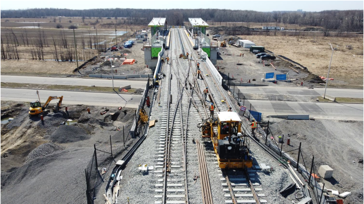
Figure 6 : Traversée oblique surélevée à la station Limebank
