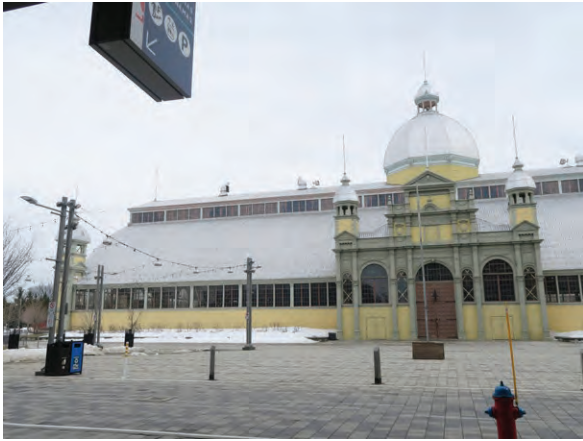
North elevation (ERA 2023)
