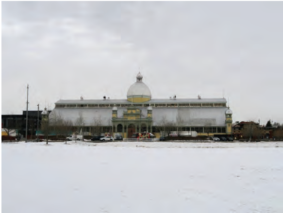
South elevation (ERA 2023)
