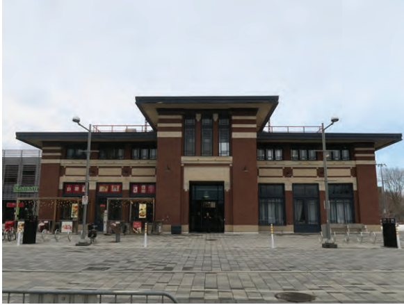
South Elevation (ERA 2023)
