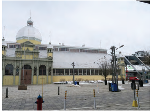
North elevation (ERA 2023)
