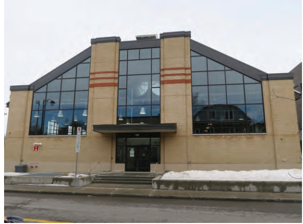
North Elevation (ERA 2023)
