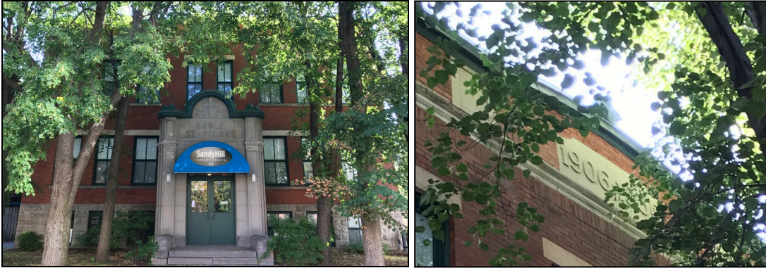
Figure 2A (à gauche) : Façade avant de l'école représentant le frontispice de pierre décoratif, les linteaux de pierre, ainsi que les fondations et les assises de fenêtre en pierre calcaire. Figure 2B (à droite) : Plan rapproché de l'entablement, de la corniche et du mur de parapet. (Ville d'Ottawa, 2019)
