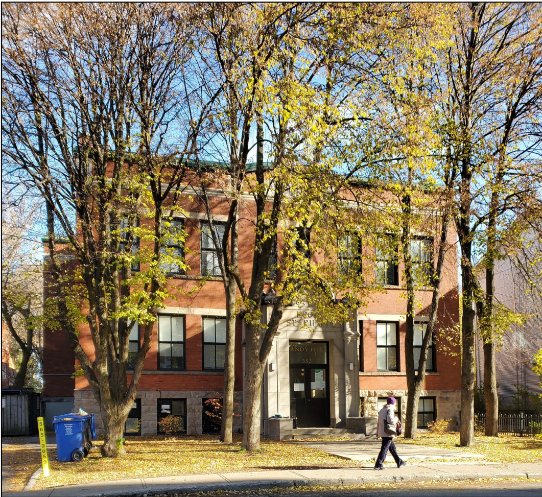
Figure 1 : 353, rue Friel : Façade avant. On peut apercevoir l'annexe arrière, bâtie en 1930. (Ville d'Ottawa, 2022)
