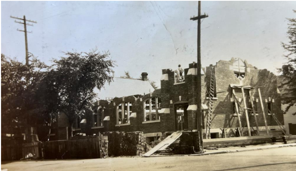
Église évangélique baptiste d'Ottawa under construction (1919-1920). Source: Bibliothèque et Archives Nationales du Québec P32,S1,D1,P9
