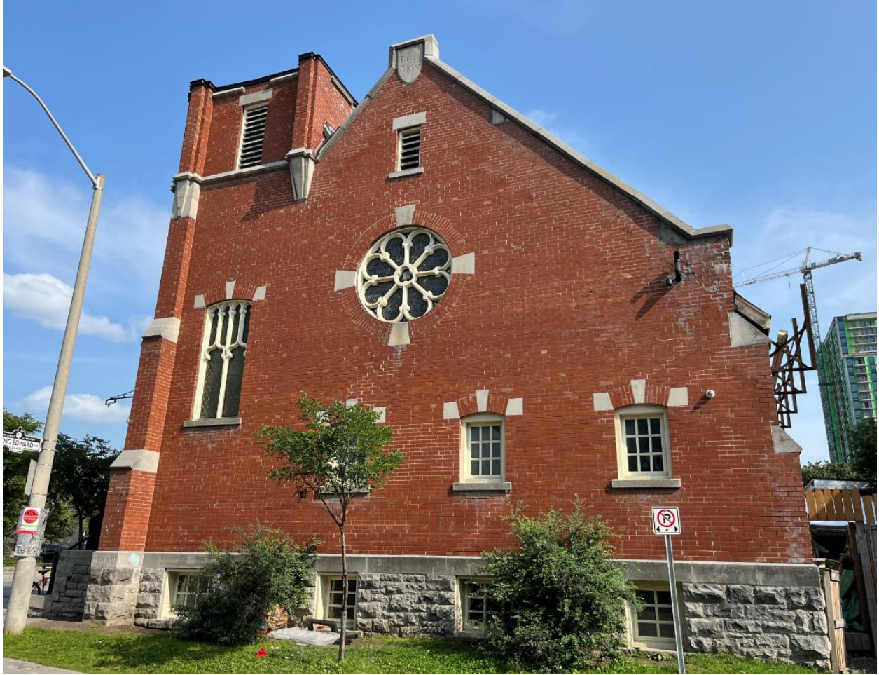
North façade of the Église évangélique baptiste d'Ottawa. Source: City of Ottawa, 2023
