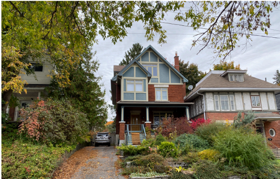
221 Sunnyside Ave / ABA
