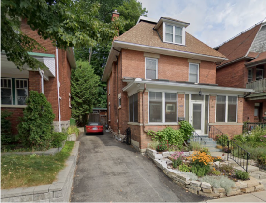
191 Sunnyside Ave / ABA
