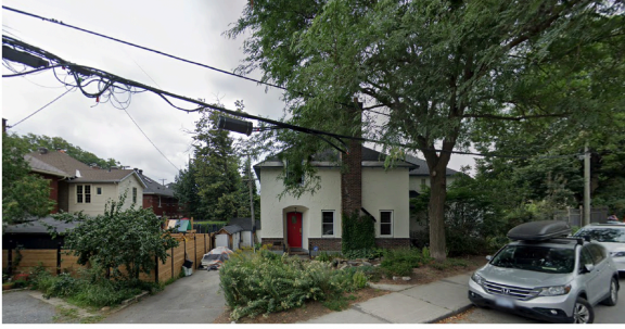
206 Sunnyside Ave / ABA
