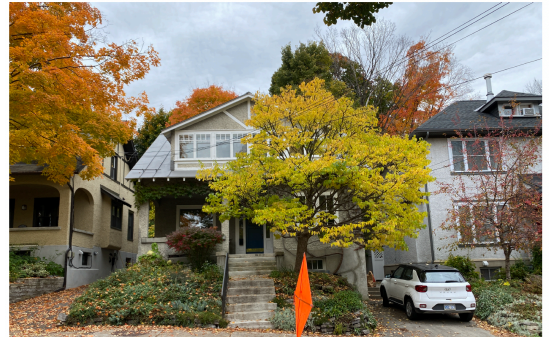
211 Sunnyside Ave / ABA
