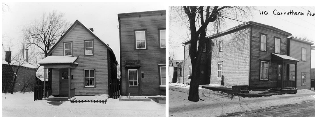
À gauche : 59, avenue Carruthers/Archives de la Ville d'Ottawa/CA024784. À droite : 110, avenue Carruthers/Archives de la Ville d'Ottawa/CA024785.
