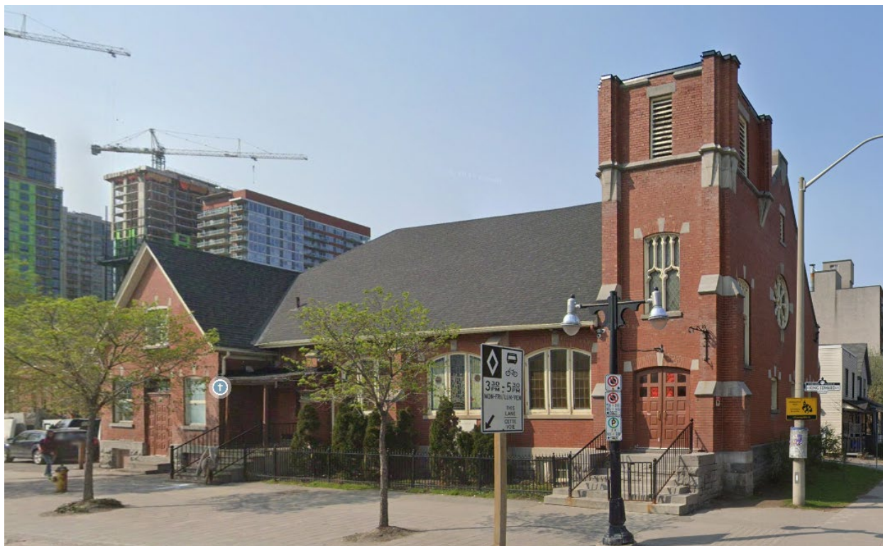
L'Église évangélique baptiste d'Ottawa, sur l'avenue King Edward à la croisée de la rue Clarence. Source : Google Streetview, 2023.
