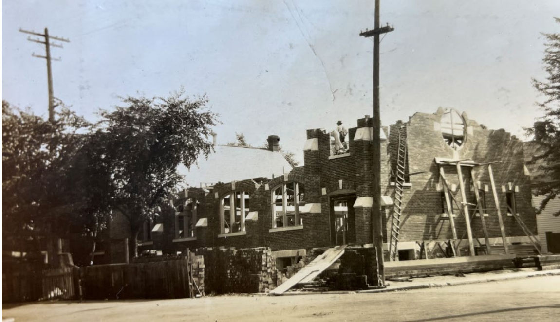
Église évangélique baptiste d'Ottawa en construction (1919-1920). Source : Bibliothèque et Archives nationales du Québec, P32, S1, D1 et P9.
