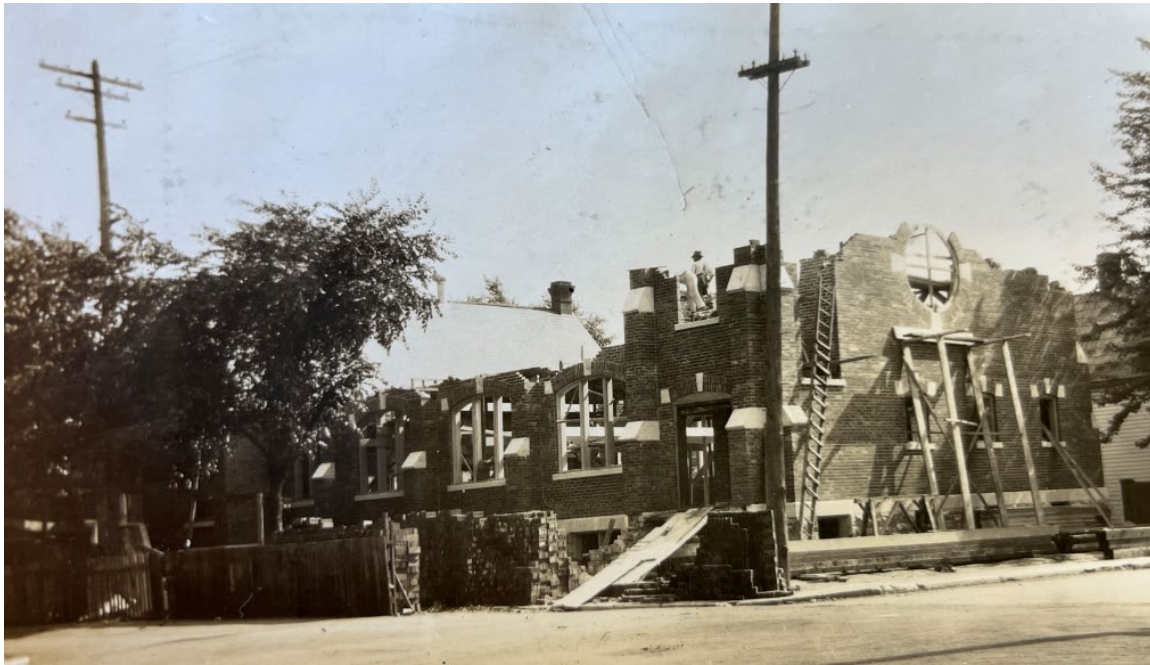
Église évangélique baptiste d'Ottawa under construction (1919-1920). Source: Bibliothèque et Archives Nationales du Québec P32,S1,D1,P9
