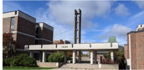
Entrance Canopy (ERA, 2021)
