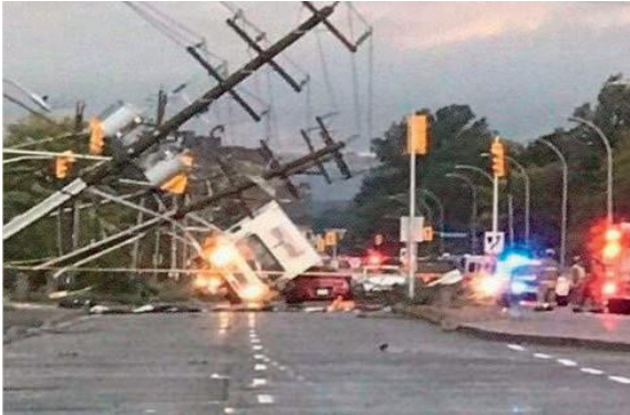
Figure 24. Les dégâts causés par une tornade
