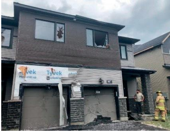
Figure 25. Les dégâts causés par une tornade
