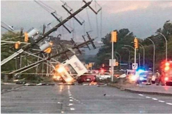
Figure 24. Les dégâts causés par une tornade
