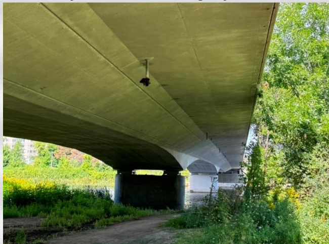
Structure 013010 – Passerelle enjambant la rivière Rideau (Pont du Transitway de l'avenue Carling enjambant la rivière Rideau)
