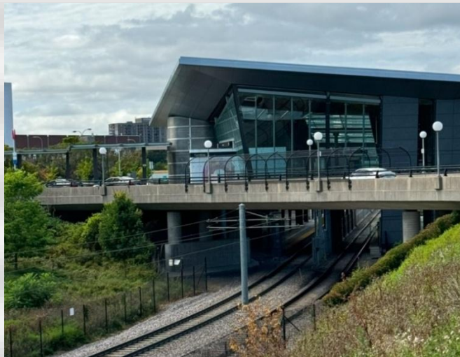
Structure 056660 – Passage inférieur de la station Tremblay (Transitway Est – Passage supérieur de la voie d'accès ouest de la station de TLR)
