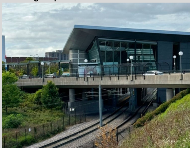
Structure 056660 – Passage inférieur de la station Tremblay (Transitway Est – Passage supérieur de la voie d'accès ouest de la station de TLR)
