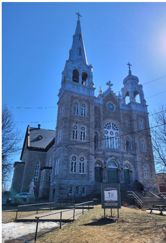
1062, rue Wellington Ouest, façade nord-est, Source: Ville d'Ottawa, 2025.
