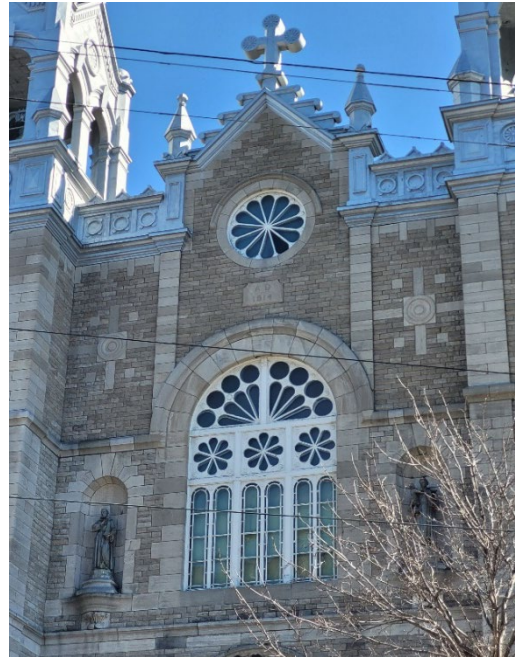
Façade nord. Source : Ville d'Ottawa, 2025.
