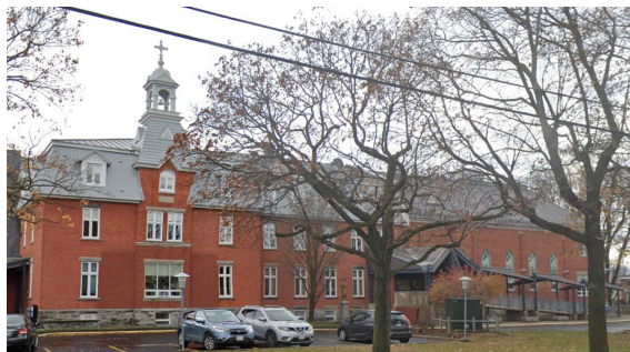
435, chemin de Montréal; annexe de 1932 à droite. Source : Google Streetview, 2024.
