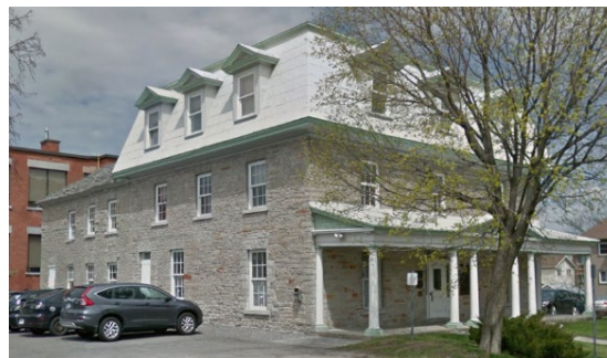
Le 35, rue Armstrong . Source : Google Streetview, 2016.
