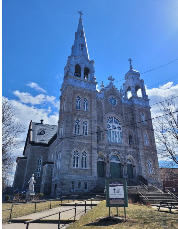
1062, rue Wellington Ouest, Source : Ville d'Ottawa, 2025.
