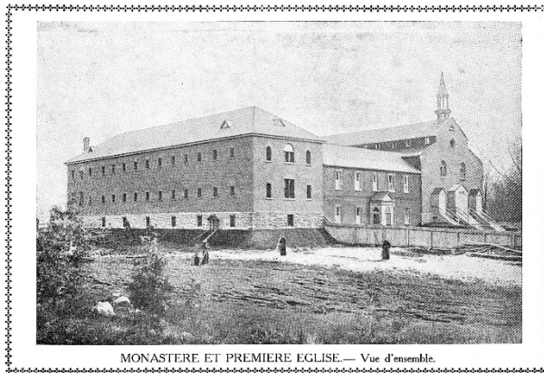
Monastère des capucins (à gauche) et première église de l'Ordre (à droite). Source : Église Saint-François-d'Assise : http://www.stfrancoisdassise.on.ca/125e.html .
