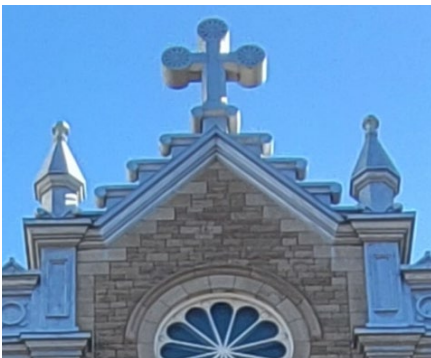
Parapet central. Source : Ville d'Ottawa, 2025.
