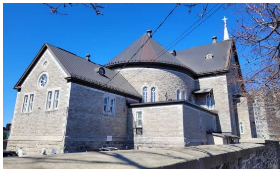
1062, rue Wellington Ouest, coin sud-est. Source : Ville d'Ottawa 2025.
