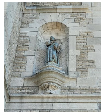
Niche statuaire de la façade nord. Source : Ville d'Ottawa, 2025.
