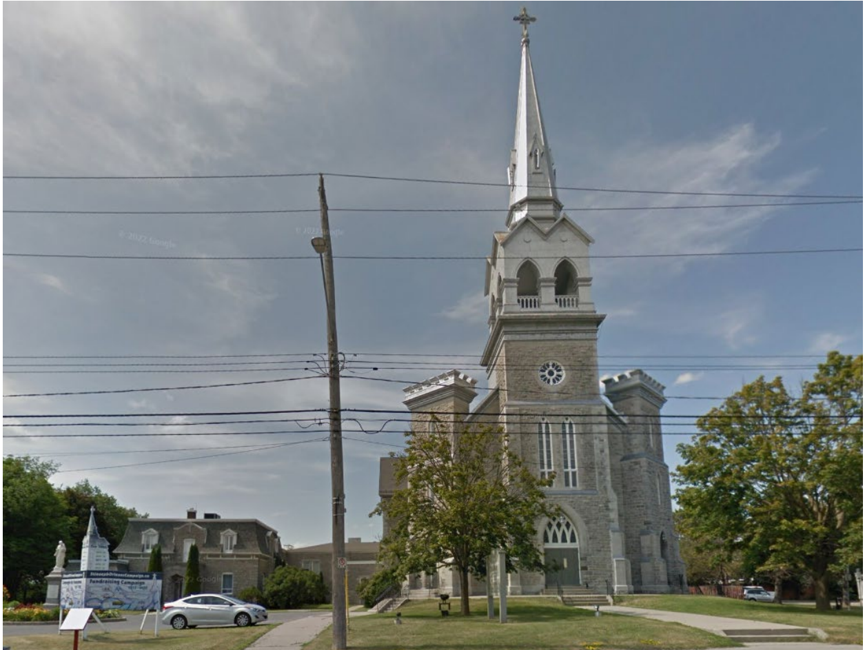
Église Saint-Joseph, élévation sud. Source : Google Streetview, juillet 2018.
