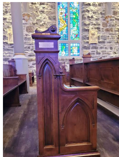
Détail d'un banc d'église. Source : Ville d'Ottawa, mars 2025.
