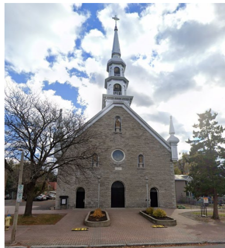
Église Sainte-Anne, 528, rue Old St-Patrick. Source : Google Streetview, novembre 2024.
