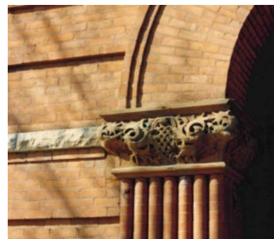
Grès sculpté et pilastres incurvés en briques de l'arche de l'entrée principale. 1991, Ville d'Ottawa.
