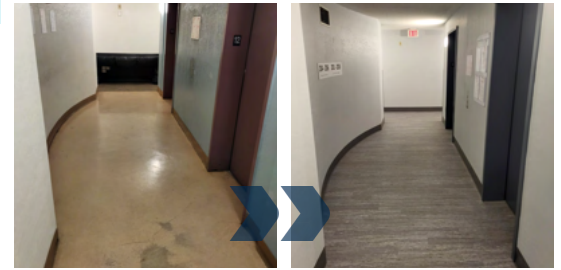
HALL D'ASCENSEUR TYPIQUE
