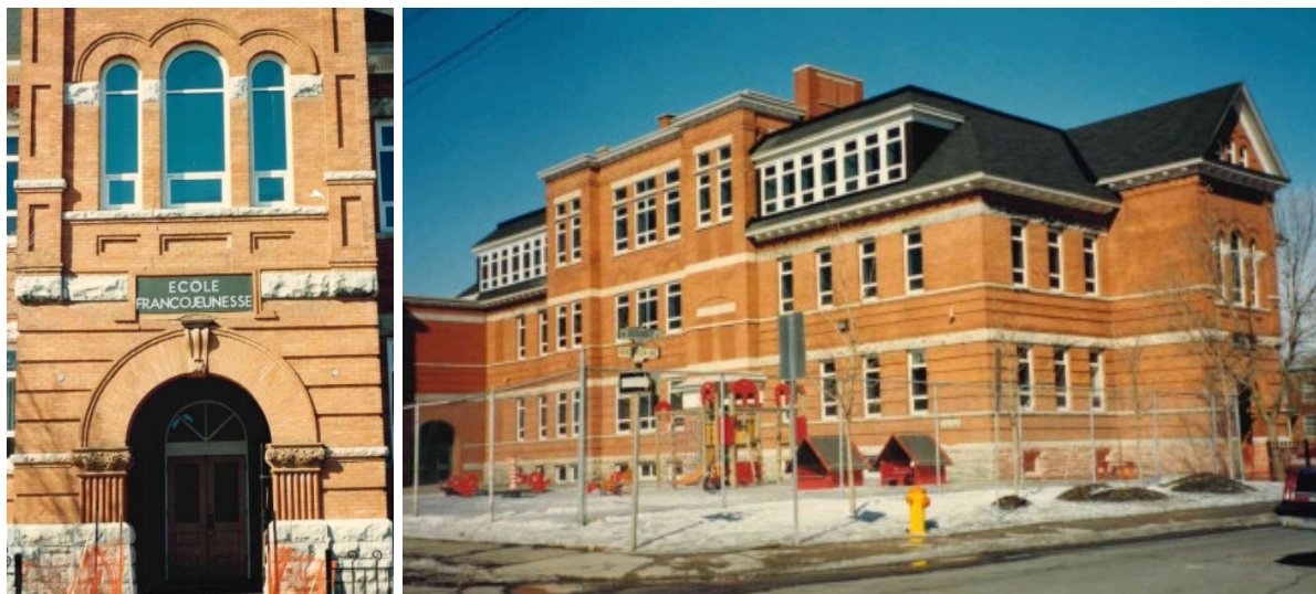
À gauche : Détail de la façade principale où figure le nom de l'école. À droite : Une cheminée marque l'emplacement du mur arrière de l'école d'origine. Images 1991, Ville d'Ottawa.
