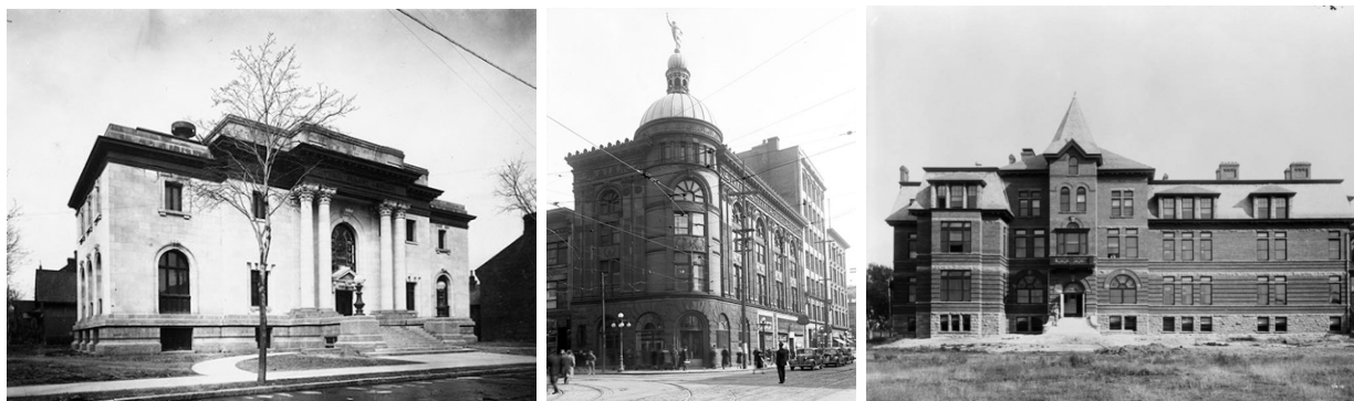
Réalisations architecturales de Horwood dans le centre-ville d'Ottawa disparues au fil des ans : la bibliothèque Carnegie, à l'angle de la rue Metcalfe et de l'avenue Laurier, vers 1909. Archives de la Ville d'Ottawa/CA002965. L'édifice Sun Life, à l'angle des rues Sparks et Bank, à Ottawa, en 1946. Archives de la Ville d'Ottawa/CA024273. Hôpital St. Luke's, 1898. Source : William James Topley/Bibliothèque et Archives Canada/PA-009066
