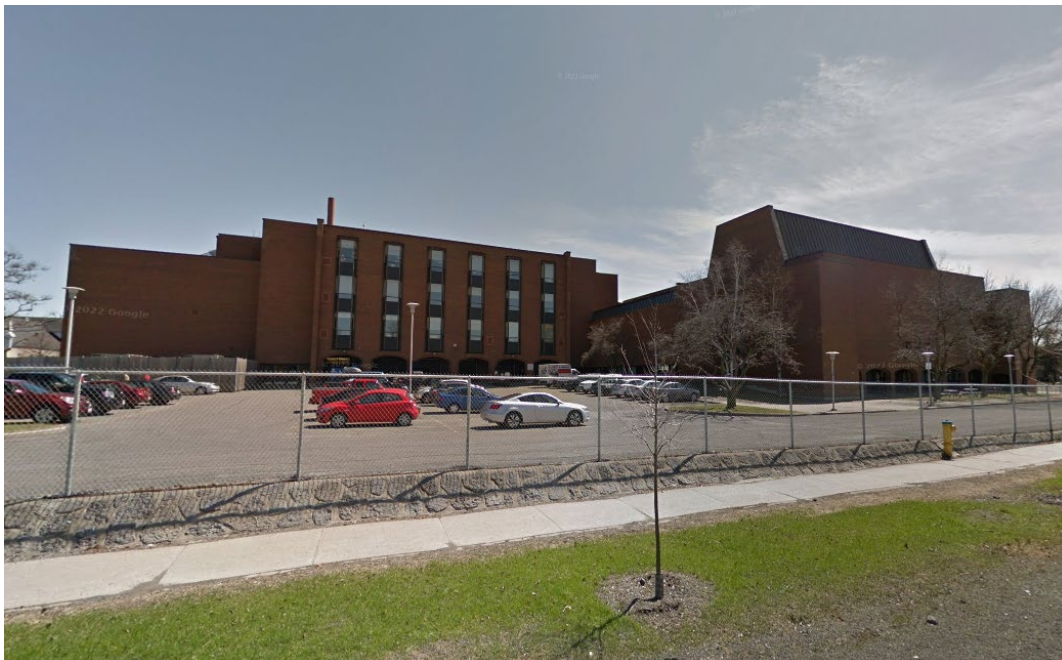
École secondaire de la Salle (Source: Google Maps, 2014).
