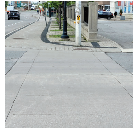
Figure 16 : Passage piétonnier rehaussé.
