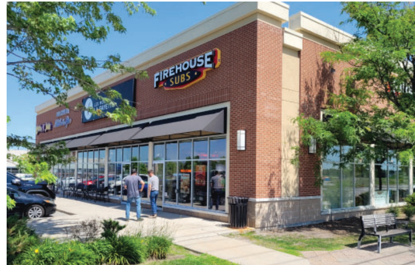
Figure 5 : Cette allée piétonnière en béton assure la liaison des entrées des différents établissements commerciaux et du trottoir public.
