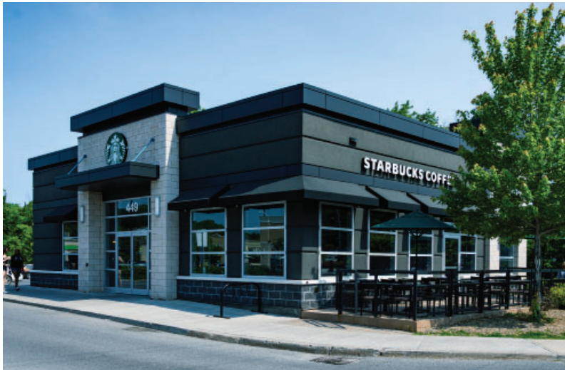
Figure 13 : Les enseignes commerciales cadrent avec la conception et l'échelle du bâtiment.
