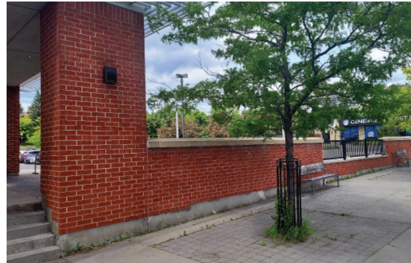
Figure 22 : Un muret masque la zone de stationnement, atténue la différence de niveau et définit les conditions de la lisière de ce projet d'aménagement.
