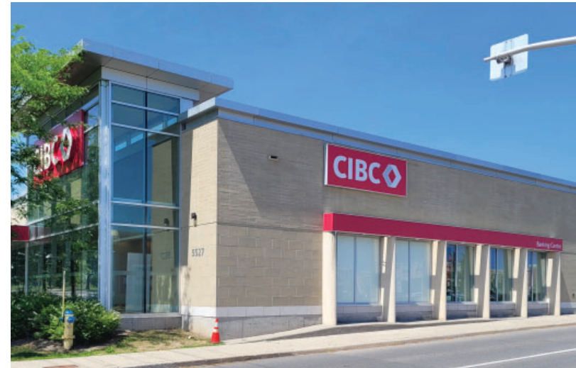
Figure 14 : Les ouvrages en saillie sur les murs et les changements de coloris et de matériaux réduisent la perception de la taille du bâtiment..
