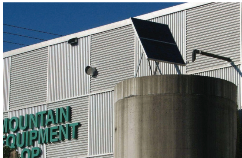
Figure 73 : Cet immeuble commercial emmagasine l'énergie solaire et les eaux pluviales.
