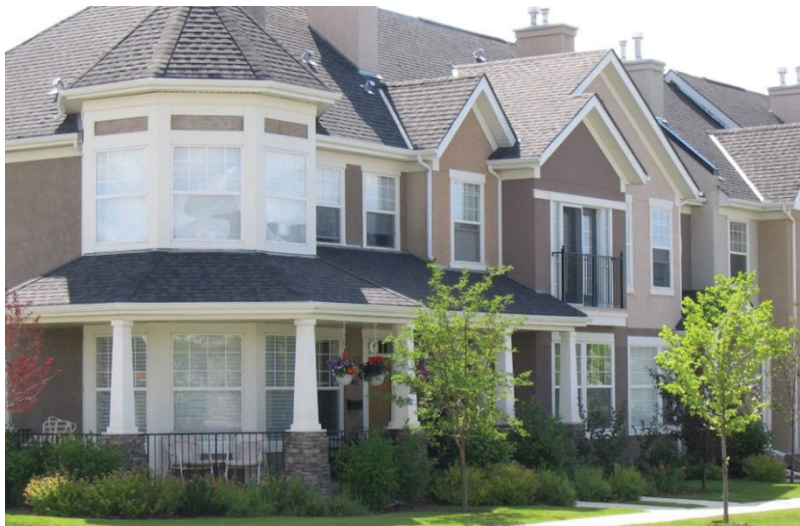
Figure 53 : Les fenêtres et la porte qui enveloppent cette habitation sur deux côtés créent un intérêt visuel sur les deux rues publiques.
