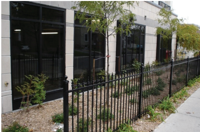
Figure 59 : Le paysagement permet de mieux masquer ce garage de stationnement du rez-de-chaussée.
