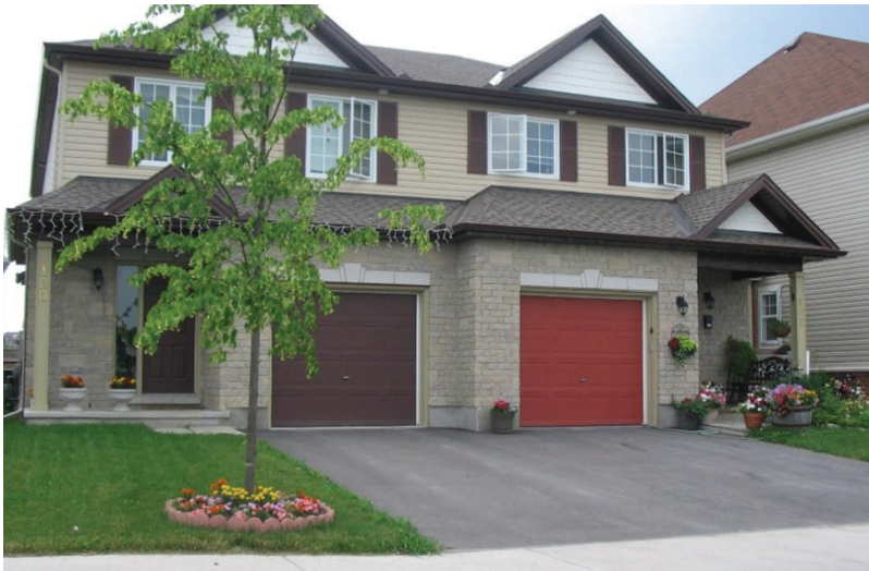
Figure 65 : Les entrées de cour communes réduisent la prépondérance visuelle des zones asphaltées.
