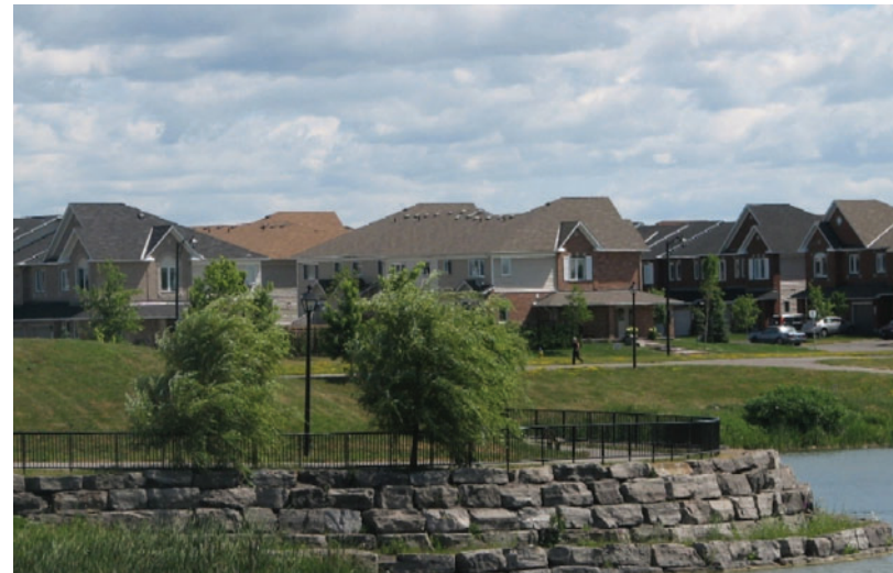
Figure 38 : L'enceinte de ce bassin de rétention des eaux pluviales cadre avec l'aménagement général de cette aire de commodité et concourt à la sécurité.
