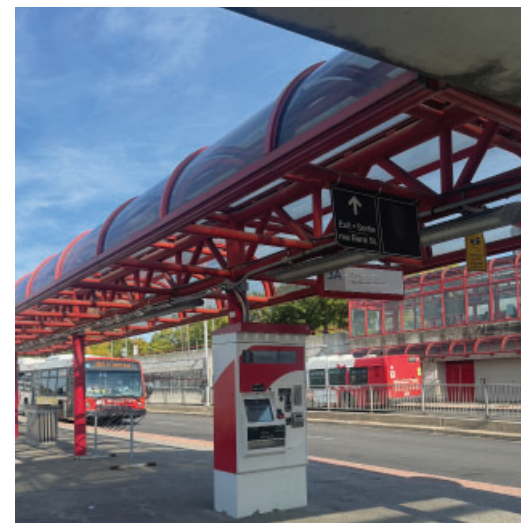
Figure 44 : L'esplanade Billings Bridge est reliée au Transitway en passant par plusieurs promenades piétonnes abritées.
