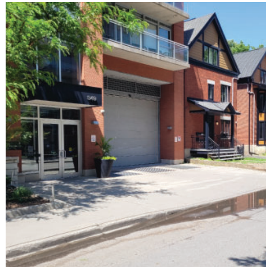
Figure 8 : Ce projet d'aménagement internalise les installations de chargement et de collecte des déchets
