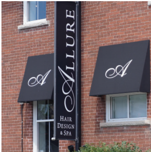
Figure 25 : Auvents posés sur la devanture d'un immeuble d'habitation donnant sur la rue, ce qui enrichit les éléments du domaine piétonnable.
