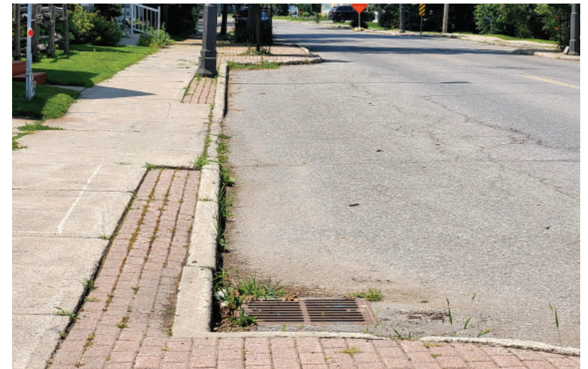
Figure 24 : Les trottoirs aménagés dans le cœur de ce village contrastent avec la voie publique et permettent de définir le domaine piétonnable. (Cumberland)
