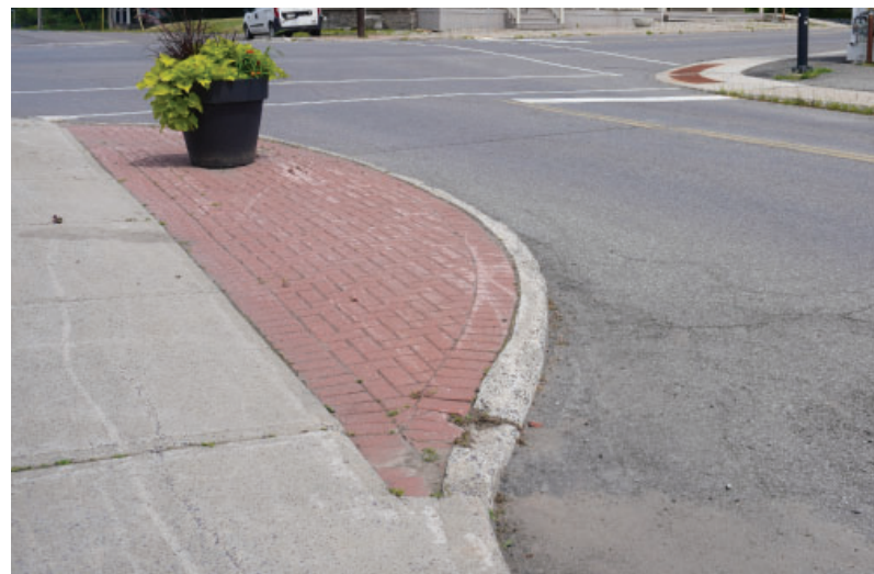
Figure 32 : Les avancées de trottoir et le changement de matériaux à l'intersection des rues dans le cœur des villages et dans les rues principales permettent de modérer la circulation.
