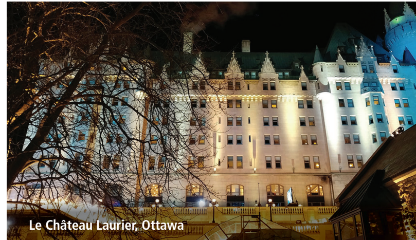
Figure 36 : L'éclairage extérieur temporaire monté pour le Championnat mondial Crushed Ice 2017 met en valeur les caractéristiques architecturales de cet édifice historique..
