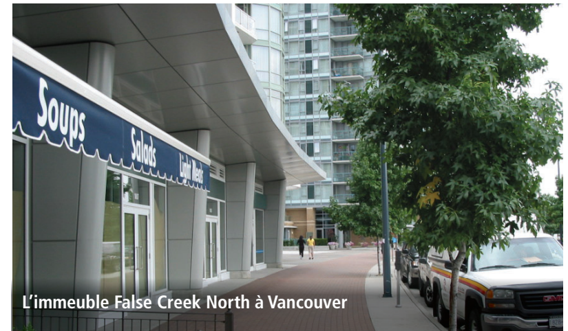
L'immeuble False Creek North à Vancouver Figure 51 : Exemple de locaux commerciaux au rez-de-chaussée dans un immeuble de grande hauteur, qui viennent animer la rue publique
