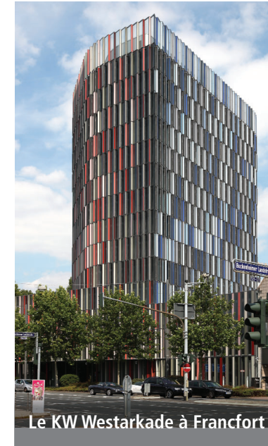
Figure 31 : L'ajout de coloris sur la façade donne une riche dimension à ce bâtiment écobienveillant.
