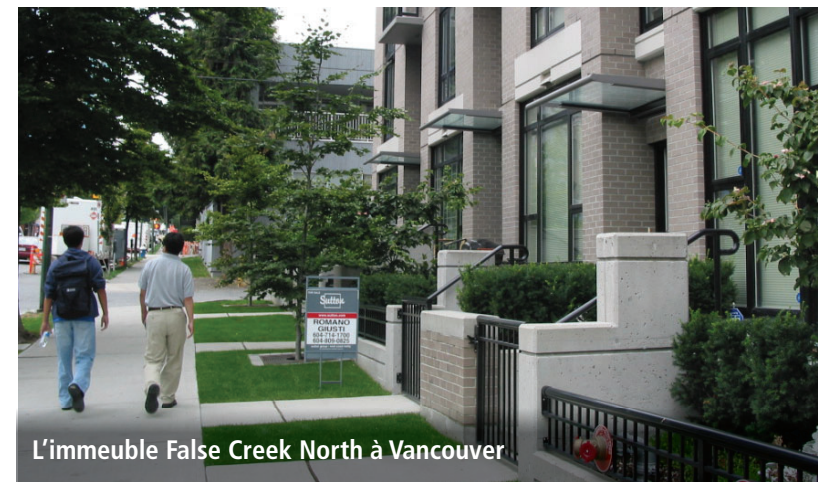
L'immeuble False Creek North à Vancouver Figure 52 : Exemple de logements orientés vers le rez-de-chaussée dans un immeuble de grande hauteur, qui viennent animer une rue publique à caractère résidentiel
