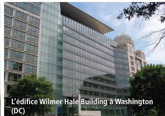
Figure 21 : La barre d'immeubles large et courte est divisée à l'horizontale et à la verticale par des articulations pour rompre la volumétrie imposante.
