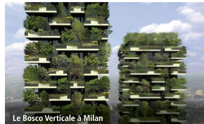
Figure 32 : Les arbres plantés dans le cadre de ce projet visent à enrayer le smog et à modérer les températures dans l'immeuble, en plus d'apporter de nombreux bienfaits environnementaux.
