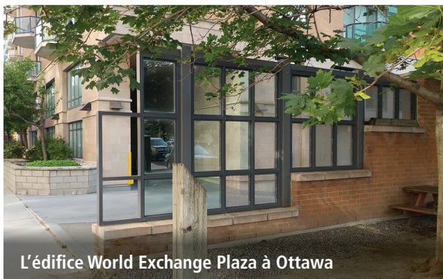
Figure 54 : Mur caractéristique conçu attentivement et qui fait partie intégrante de l'expression architecturale globale; il sert d'écran pour l'entrée de l'embarcadère et du garage.
