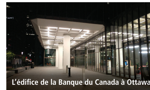
Figure 39 : L'éclairage intérieur au rez-de-chaussée et sous la colonnade vient créer un environnement piétonnier lumineux, sécuritaire et invitant.
