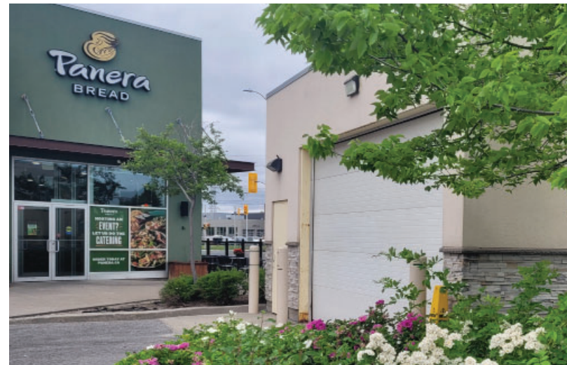
Figure 22 : Les matériaux et la conception de ce bâtiment de service reprennent les matériaux et la conception du bâtiment principal.
