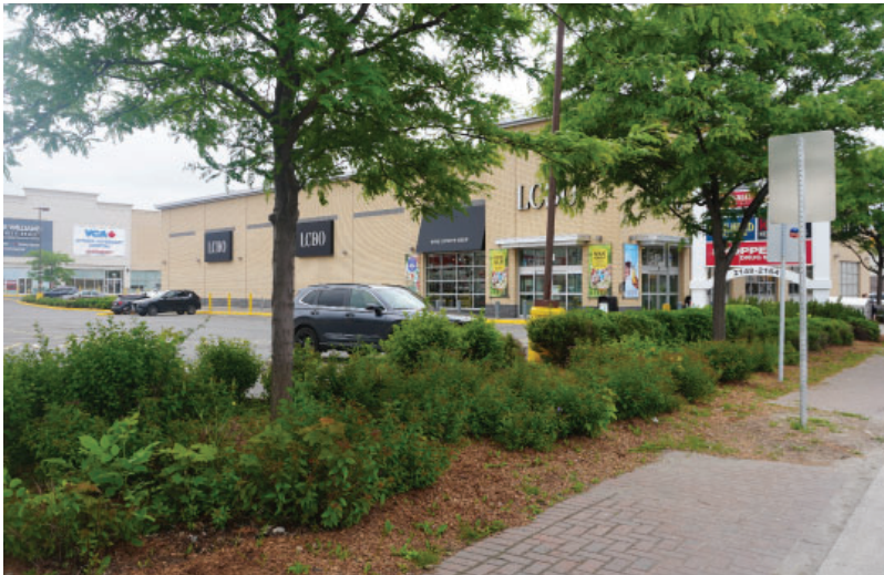
Figure 14 : Des arbres sont plantés le long de cette façade publique.
