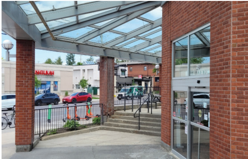
Figure 5 : Les auvents en verre de ce bâtiment protègent les piétons contre les intempéries.
