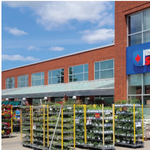
Figure 2 : Le premier et le deuxième étages de ce bâtiment sont dotés de fenêtres vitrées.
