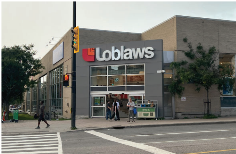
Figure 27 : Une tour de coin et les changements de coloris et de matériaux augmentent l'attrait de la façade de ce bâtiment dans l'angle.
