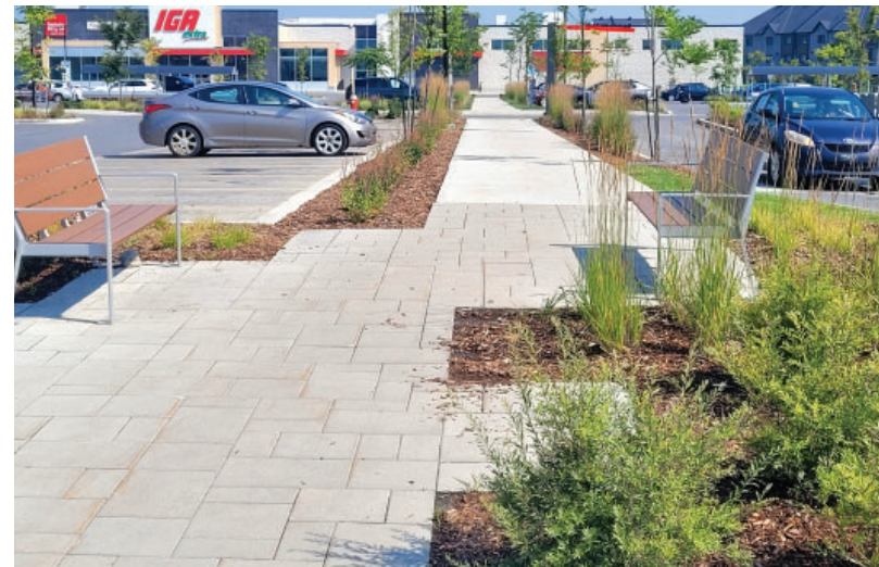
Figure 36 : L'aménagement d'un revêtement perméable et le paysage végétalisé dans l'allée piétonne augmentent l'attrait visuel, en plus de réduire le ruissellement des eaux pluviales.
