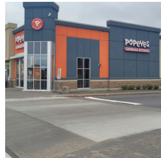
Figure 12 : Les allées piétonnes surélevées rehaussent la sécurité pour les piétons qui traversent les voies d'accès privées.
