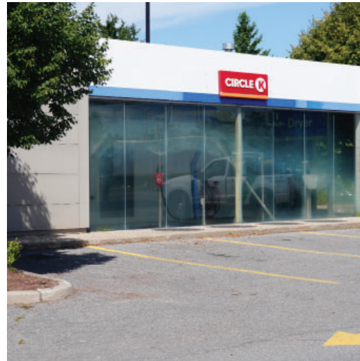
Figure 4 : Les fenêtres de verre de ce lave auto donnent sur la zone publique.
