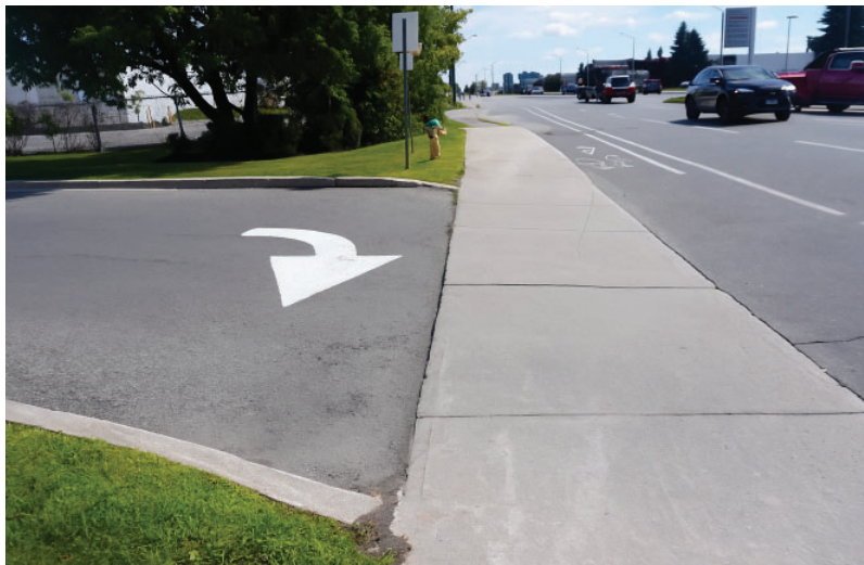
Figure 10 : La voie d'accès est assez large pour éviter les conflits avec les piétons sur le trottoir.
