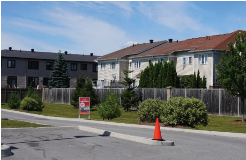
Figure 12 : Une zone tampon paysagée luxuriante est aménagée le long de la clôture du site non loin de la voie de sortie du lave auto.
