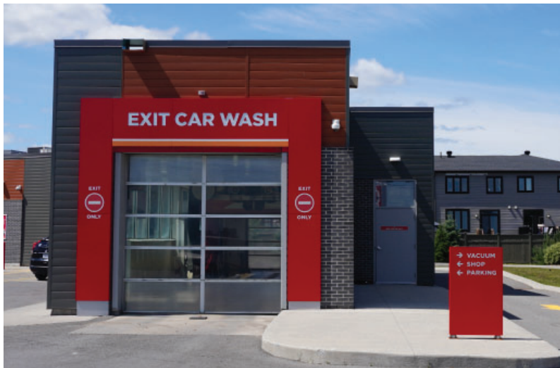
Figure 19 : Le lave auto prévoit pour l'enseigne un espace défini qui respecte l'échelle du bâtiment.
