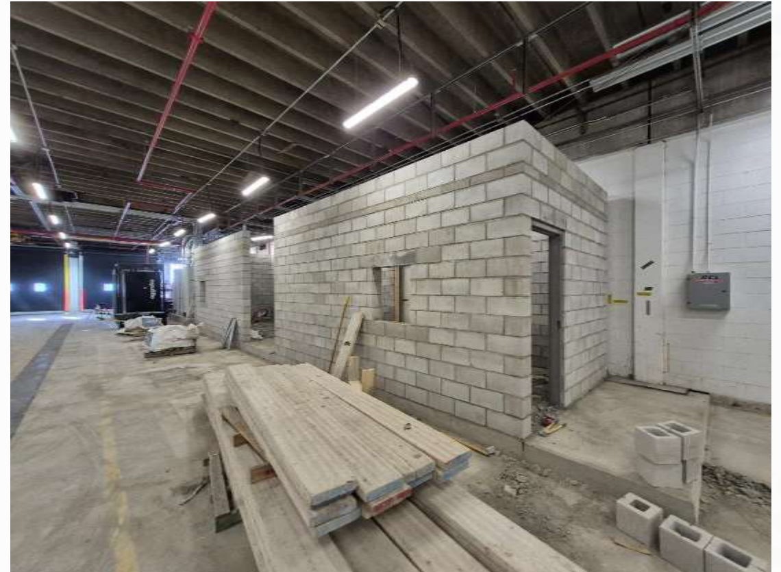
Construction d'une salle électrique
