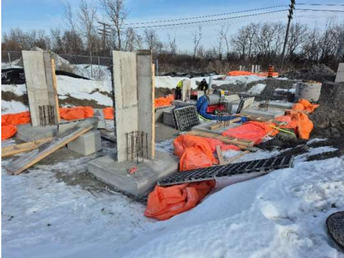
Fondation pour équipement électrique
