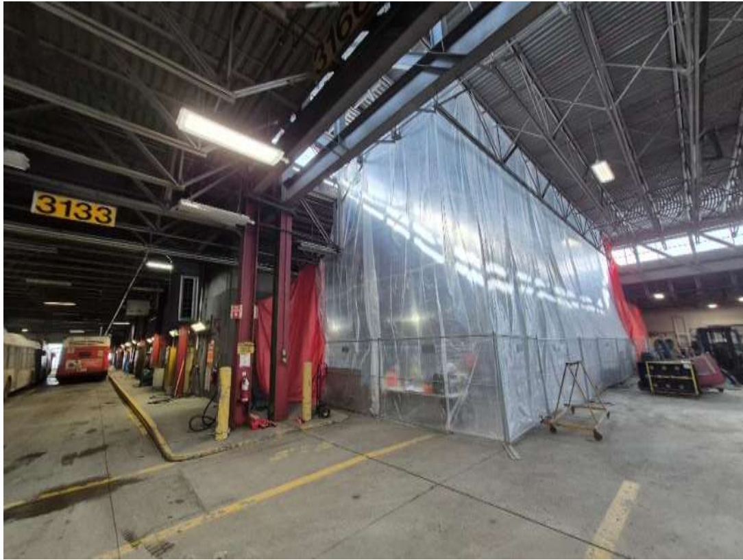
Lieu d'entreposage des matériaux à l'intérieur
