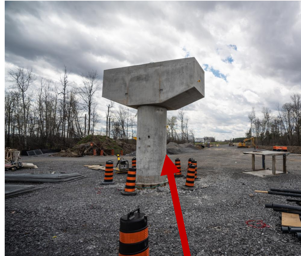
Infrastructure (ouest) de la promenade Uplands
