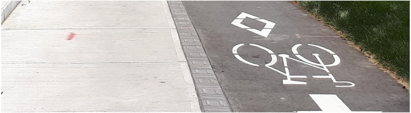
Figure 1 – Piste cyclable asphaltée séparée d'un trottoir en béton par une bande de délinéation tactile
