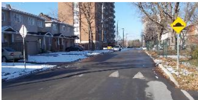
Figure 2 – Dos-d'âne allongé et signalisation
