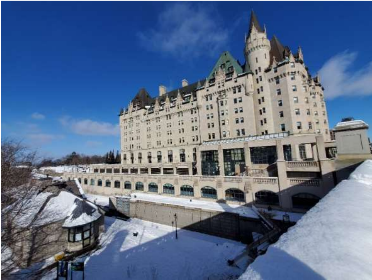
Vue sur la façade ouest, les écluses d'Ottawa et le bureau du maître-éclusier
