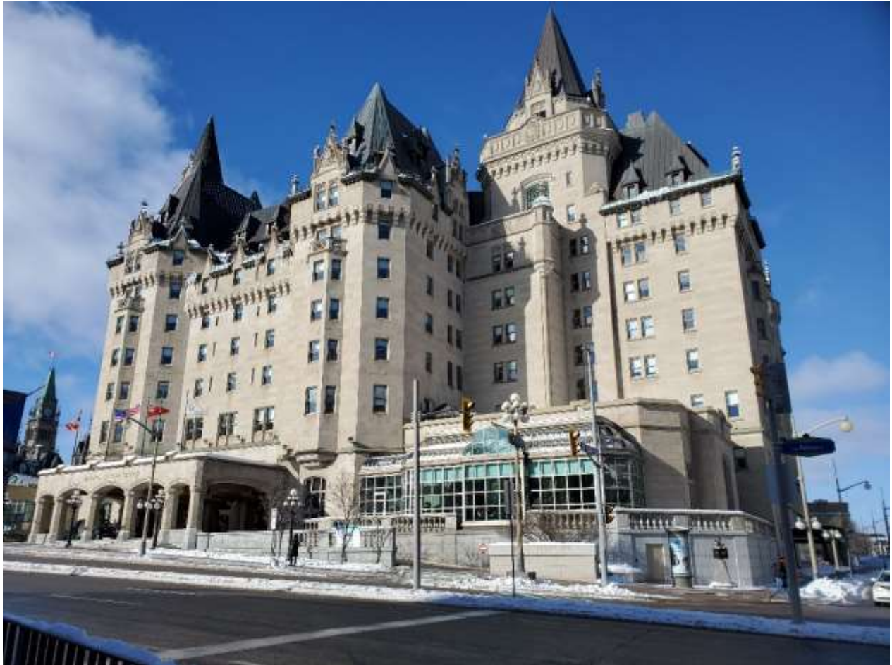
Vue sur la façade avant montrant l'annexe des années 1920
