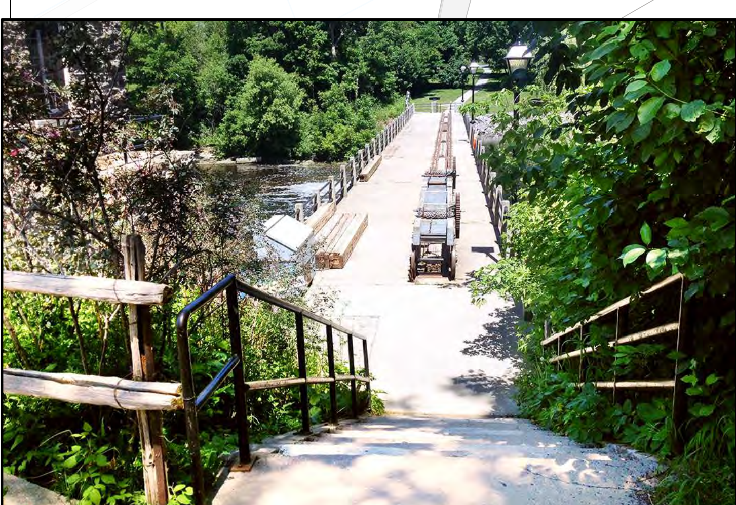
Existing stairs at Parks Canada Dam Escalier actuel du barrage de Parcs Canada
